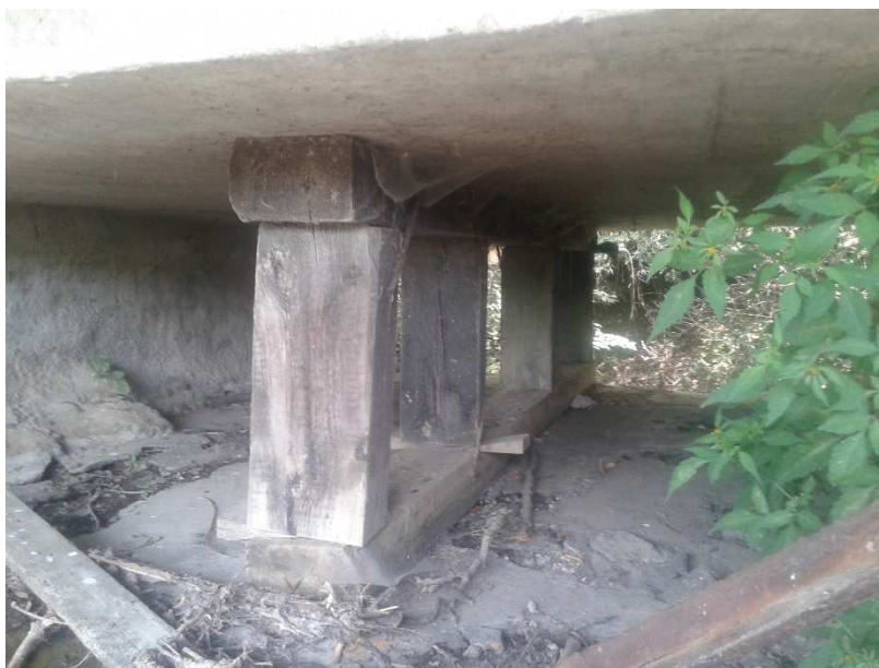
Foto č.5 – Provizorní podepření mostu dřevěnou bárkou.
