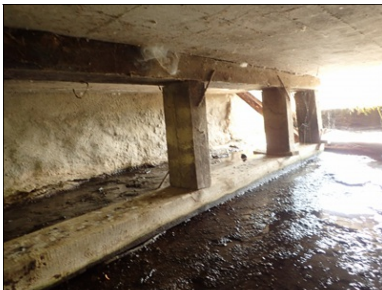
Podhled rozšíření NK pod chodníkem na L straně.
