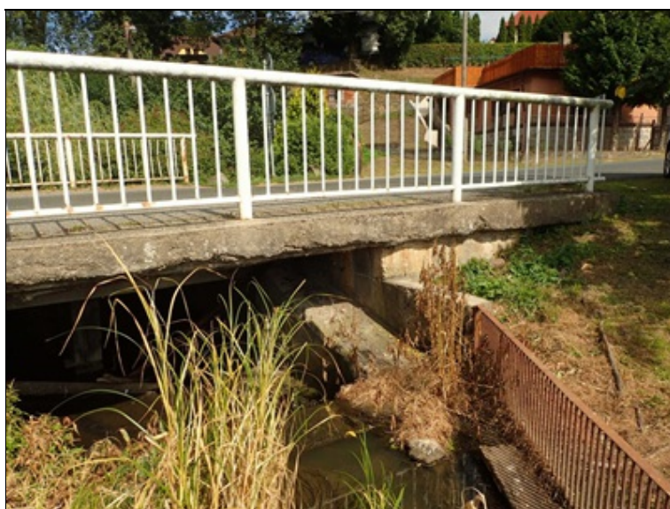
Levý bok objektu, rozšířená O1, přeliv rybníka s česlemi.
