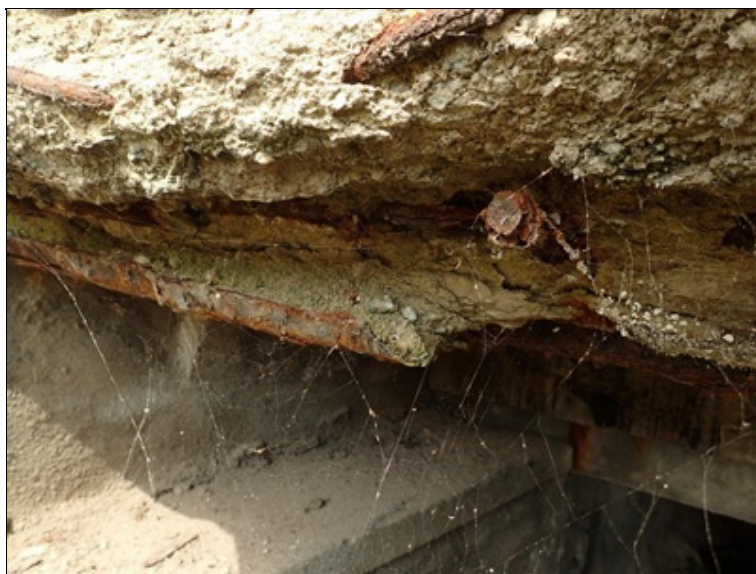
Podhled NK rozšíření pod chodníkem na styku s původní řimsou. Odpadlé bednění, styčná spára s původní řimsou vyplněna kameny a nečistotami.
